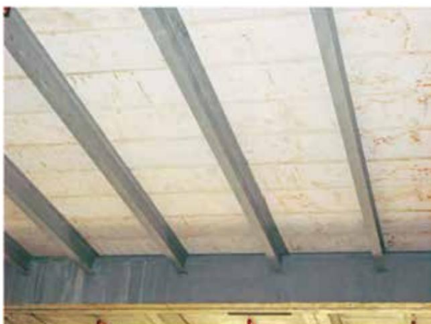
Acier fixe de type C avec poutre principale de type H
